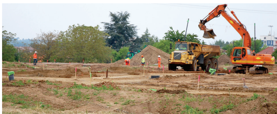
Début des travaux de viabilisation
