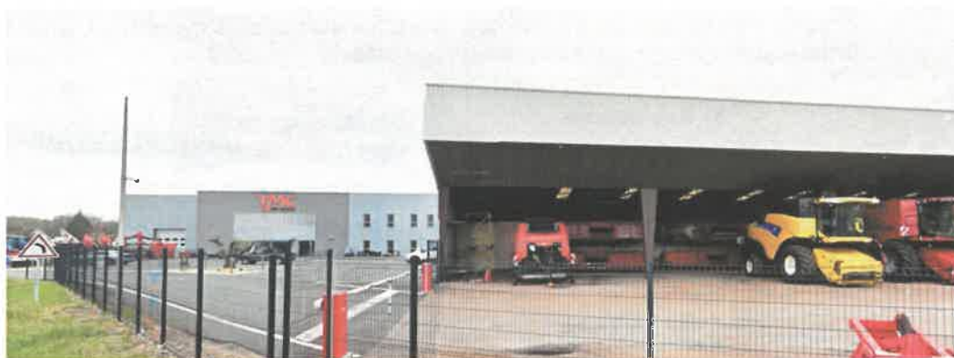
Vue sur le bâti de l'entreprise TMC Bejenne depuis la RD 910 (Source : ©Google Street View, 2023)
