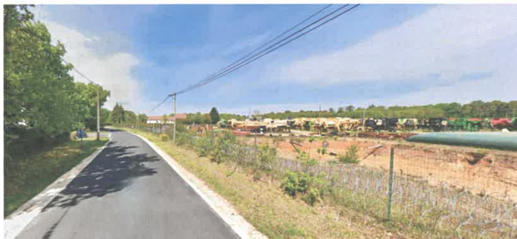
Vue du site depuis la route de la Glandée : c'est la voie qui offre la perception la plus dégagée du site (Source : ©Google Street View, 2022)
